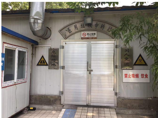
省立医院中心院区医用垃圾中转站
