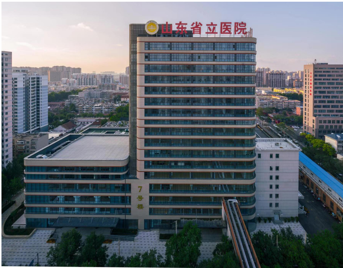
图 2.2-2 综合楼航拍图
