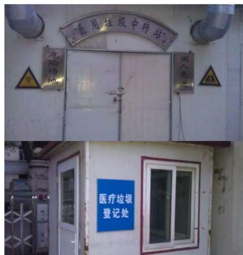
医疗废物暂存间危废标志牌
